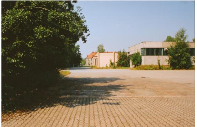
Industriehallen auf dem ehemaligen Appellplatz, 1990er Jahre.
