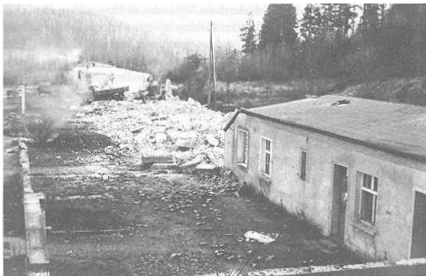
← Der Abriss des ehemaligen Arrestbaus, ca. 1965. Fotos: unbek. Fotograf, KZ-Gedenkstätte Flossenbürg.
