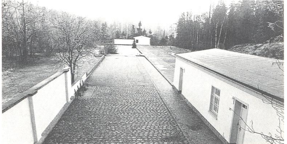
Der erhalten gebliebene Teil des ehemaligen Arrestbaus, 1988. Foto: Franz Schöttner.
