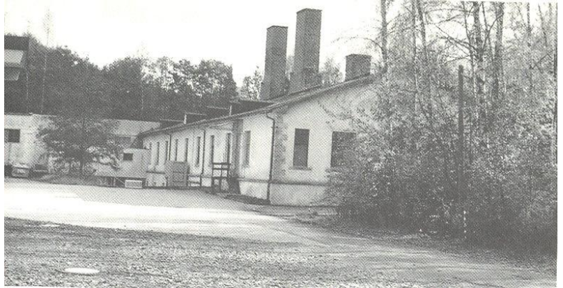
Das Gebäude von Häftlingsbad und Wäscherei, im Jahre 1988 als Bürogebäude genutzt.
